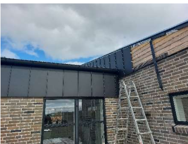
Beklædning af murværk over køkken
